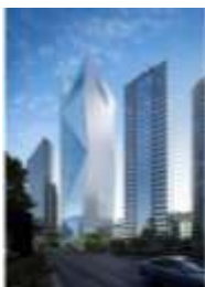
Visite du chantier de la tour Carpe Diem à la Défense
